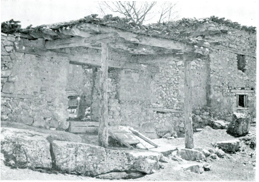
Res. 4 — Batı cephe, avluya giriş kapısı
