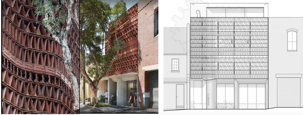
Şekil 2. Beehive Ofis yapısında atık kiremitin cephede kullanımı (Arkitera, 2018)
