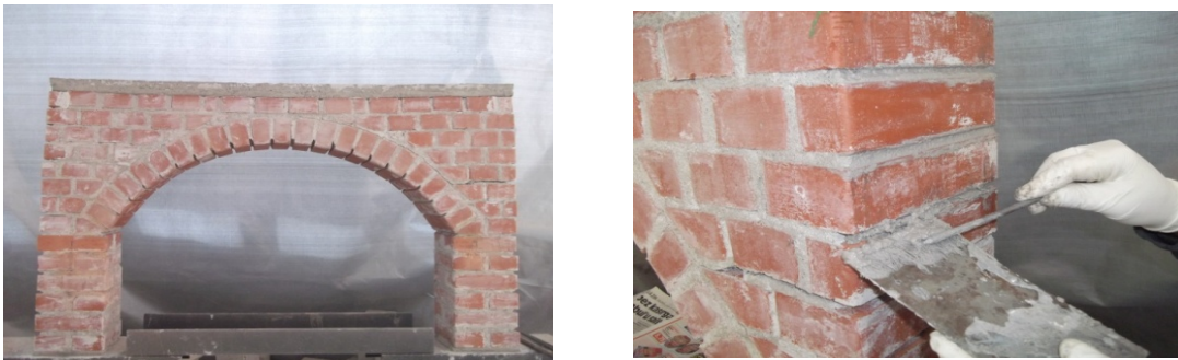
Şekil 10. Derzlerin epoksi harcı ile doldurulması (The filling of epoxy resin in joints)
