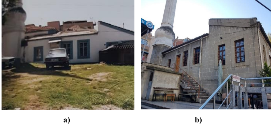
Şekil 15.a) Doğu cephesi 1990'lar (Koruma Kurulu Arşivi,1993), b) Doğu Cephesi 2019 yılı
