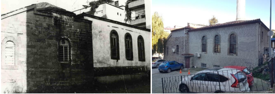
Şekil 12. a) Hatuncuk Hatun Camii Batı Duvarı 1974 (V.G.M Arşivi) b) 2019 yılındaki durumu
