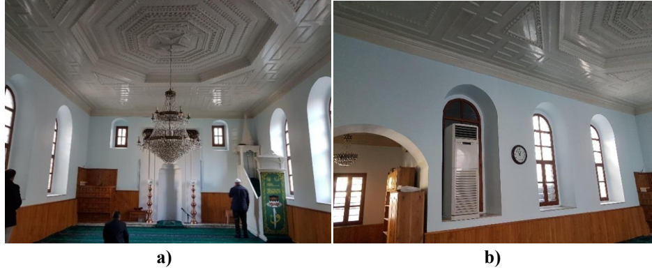
Şekil 17. a) Harim bölümü güney duvarı. b) Harim bölümü doğu duvarı
