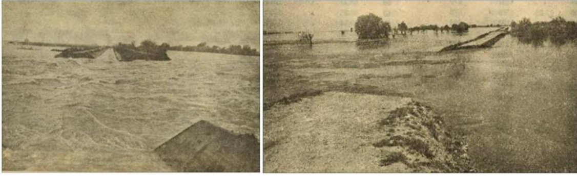
Şekil 6. Seyhan sol ve sağ seddeden bir sedde yırtığı fotoğrafları [39]
