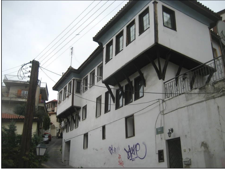
Şekil 6. Türk ve Yunan mimarisinde özgün bir yeri bulunan cumbalı evler gibi taşınmazların pek çoğu 1923-1925 arasında hızla el değiştirmiştir. Üst katları dışa çıkıntı veren ve payandalarla desteklenen bu yapıların günümüzdeki örneklerinin bazıları iki taraf nezdinde de hala kullanılmaktadır. Görselde bu tip evlerin Yunanistan/Kavala'da bulunan bir örneği yer almaktadır. Kaynak. Burak BOYRAZ Arşivi / Kavala, 2014.
