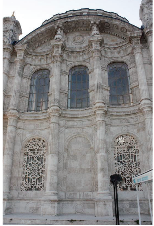
Foto. 6: Ortaköy Camii, Beden Duvarları ve Pencereleri
