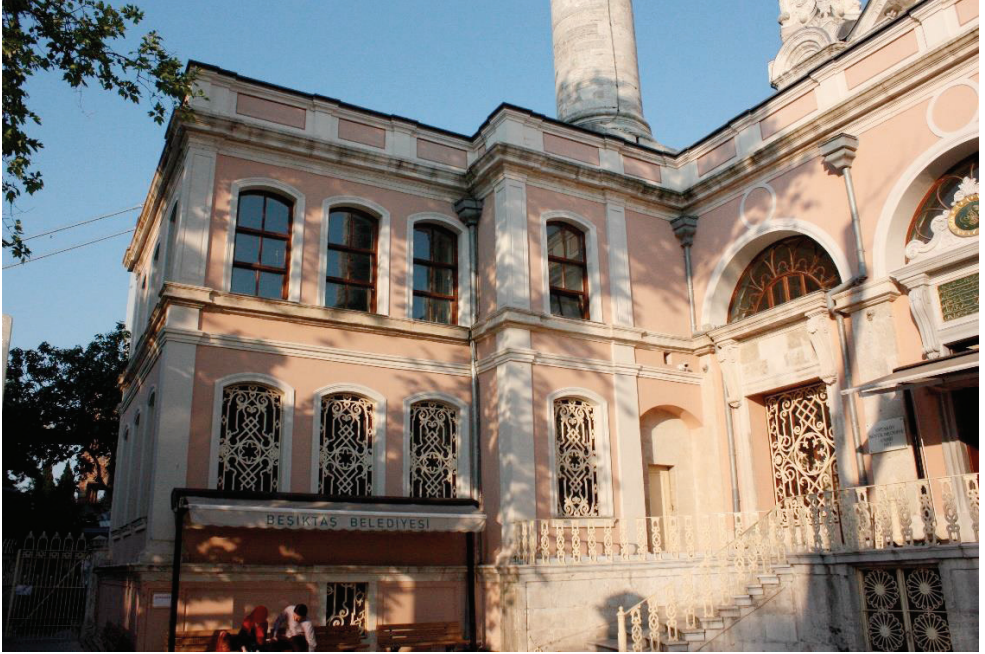
Foto. 10: Ortaköy Camii, Doğu Cephesi Mektep Binası
