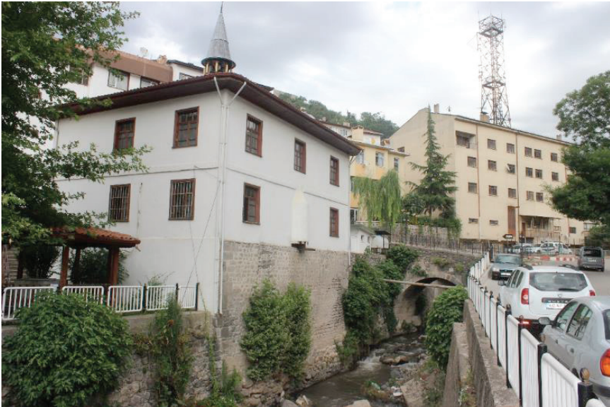
Foto. 28: Niksar Çilhane Camii Genel Görünüş
