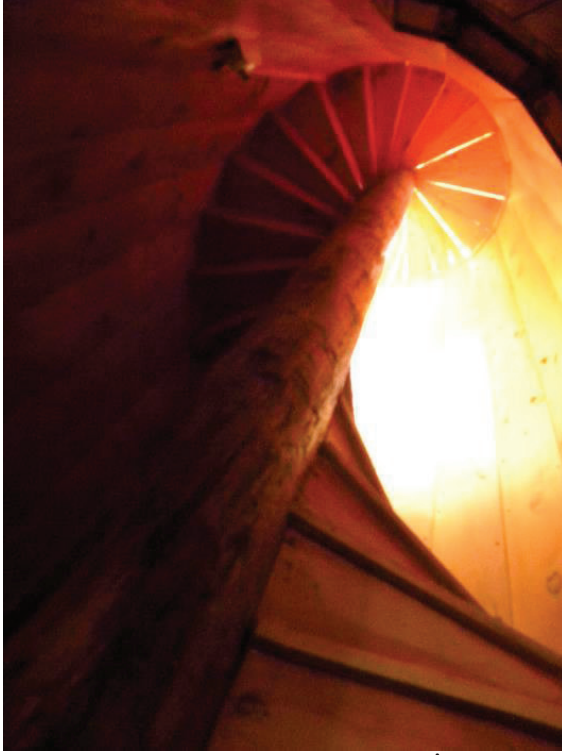
Foto. 5: Ahî Paşa Camii Minare İç Kısım
