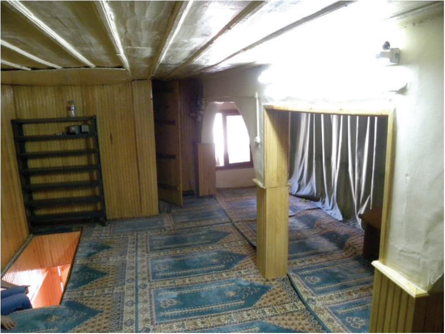
Foto. 18: Seyyid Necmeddin Camii Minare Girişi
