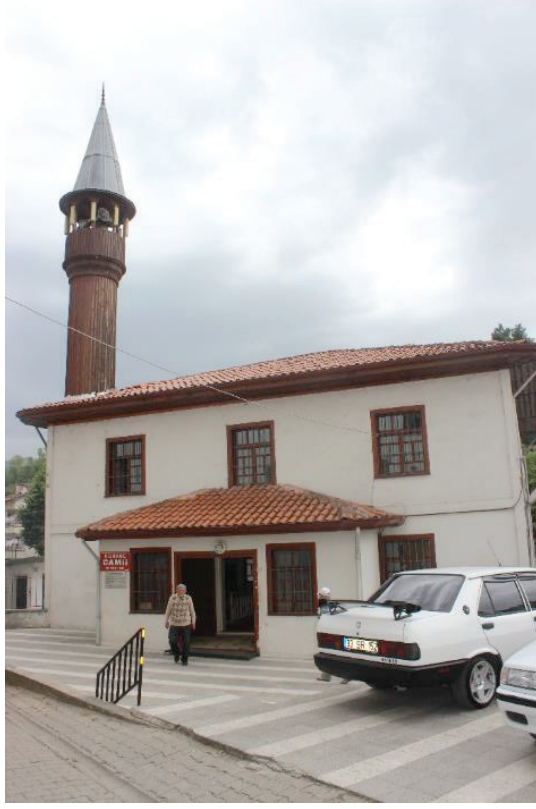
Foto. 27: Niksar Çilhane Camii Genel Görünüş
