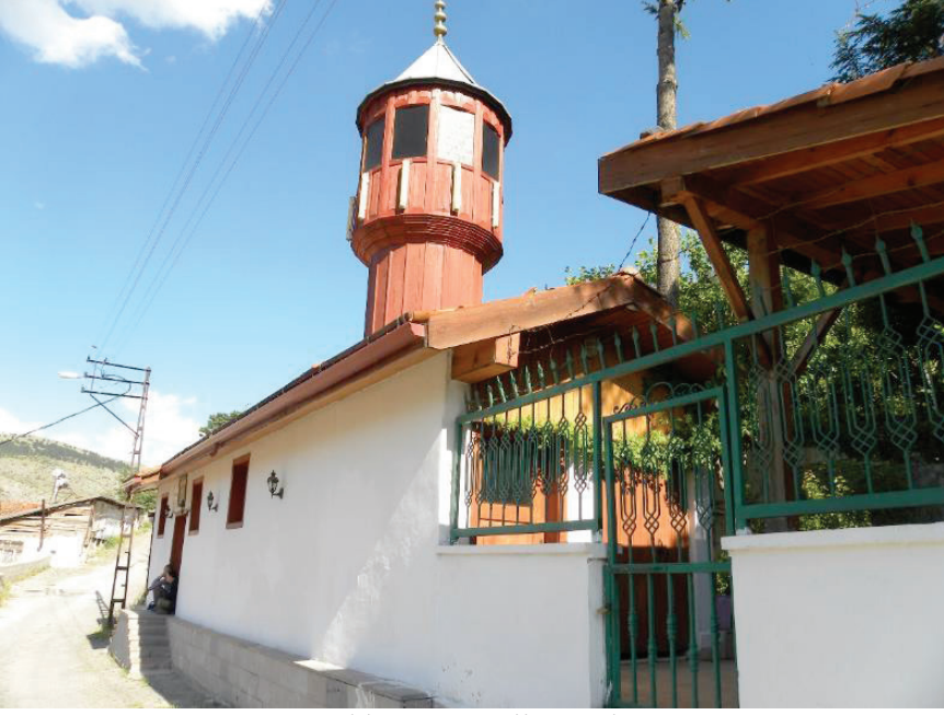
Foto. 1: Ahi Paşa Camii Genel Görünüş
