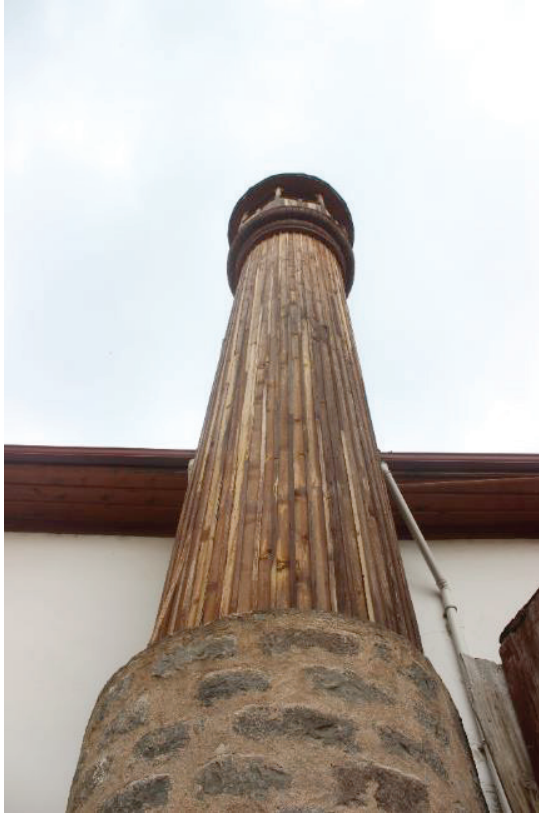
Foto. 36: Niksar Hanegah Camii Minare Detay
