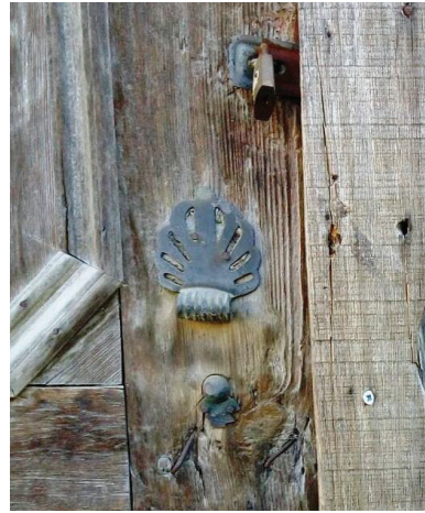
Foto.12: Musalla Mahallesi Göcenler Sokak, No: 24.
