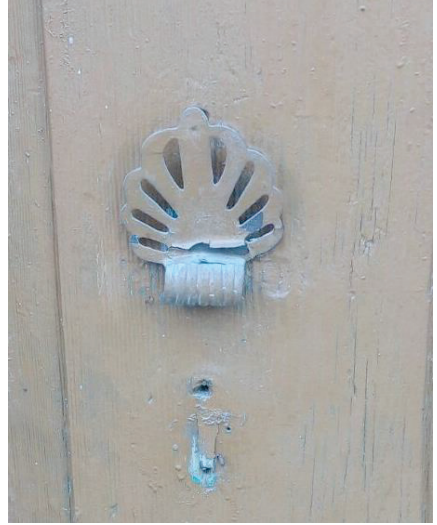
Foto. 14: Üstatlar Mahallesi, Kız Mektep Sokak, No: 13.
