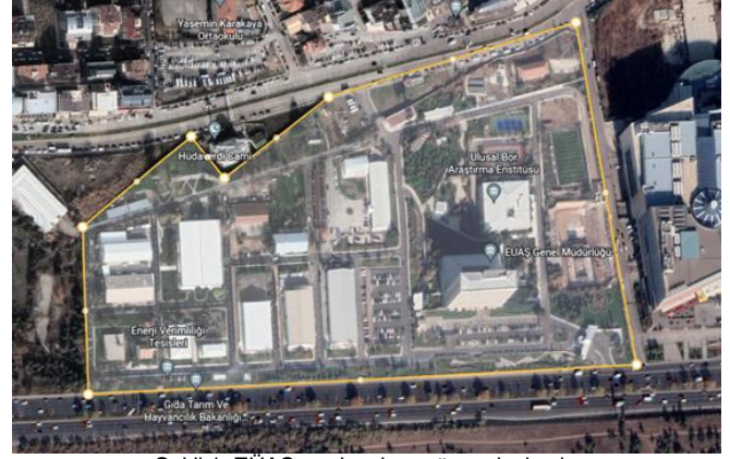
Şekil 1. EÜAŞ merkez kampüs yerleşkesi.
