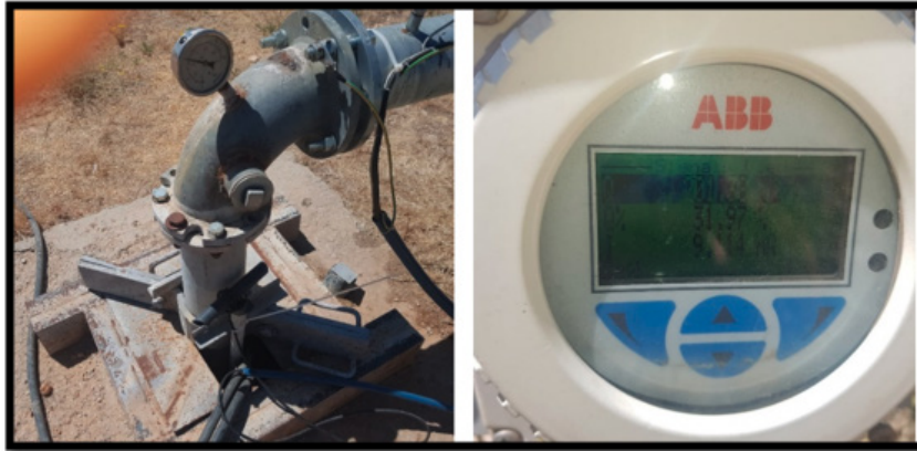
Şekil 9. Üretim kuyularına yerleştirilen debimetreler (EÜAŞ, 2020)
