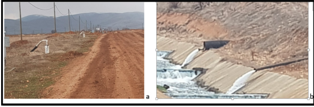
Şekil 8. a: Geçirimliği düşük birimlerde açılmış, b: karstik birimlerde açılmış kuyular (EÜAŞ, 2020)
