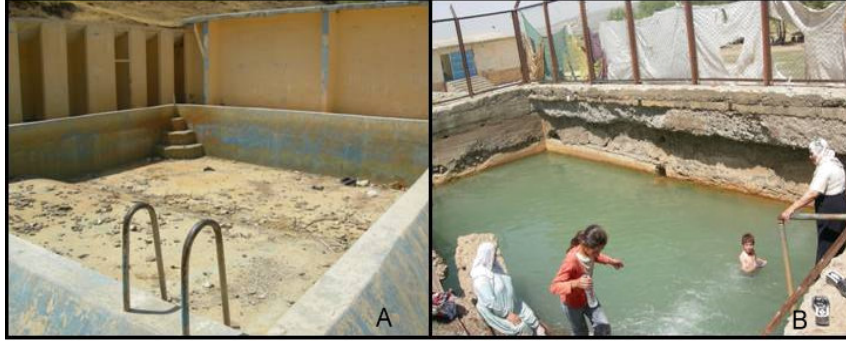
Foto 2: Ağustos 2006 tarihi itibariyle yıkılmış bir halde olan kaplıca tesisi (A). Doğu kaynağı üzerinde yer alan havuz (B).
