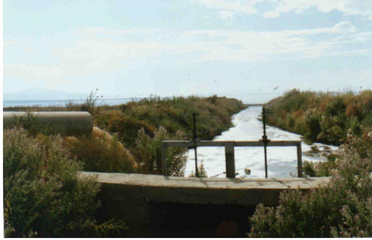
Foto 5. Kentin Arıtma Tesisinde Göle Boşaltılan Atıksulardan bir Görüntü
