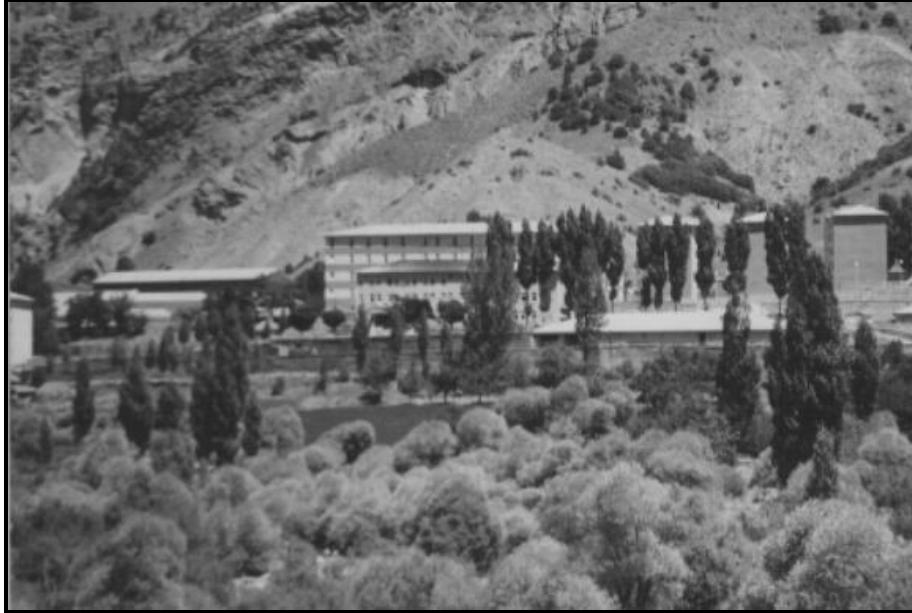
Fotoğraf 5. Pülümür ve yakın çevresinin en önemli eğitim kurumu olan ve 27 Ocak 2003 depreminde ağır hasar gören Pülümür Yatılı İlköğretim Bölge Okulu.
