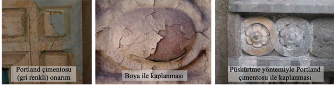
Şekil 1. Doğal çimento bulunan tarihi yapıların uygun olmayan malzemeler ile onarımı [5] (Repair historical natural cement applications with unsuitable materials)
