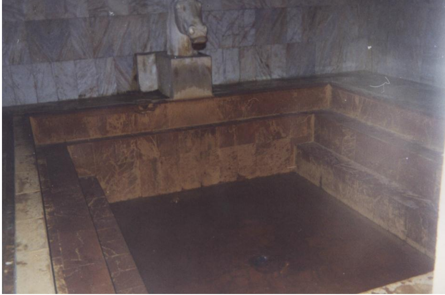
Fotoğraf 3: Küçük Kaplıca’da ortasında 1.5 metre derinlikte bir havuz ve 8.30 metre çapında bir kubbe ile örtülü ana mekân bulunmaktadır.
