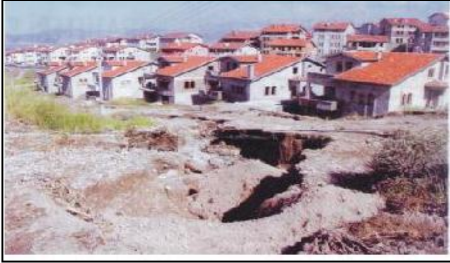
Foto-3. Isparta'nın Binbirevler Mahallesiinde şiddetli yağışlardan sonra ortaya çıkan tahribat.
