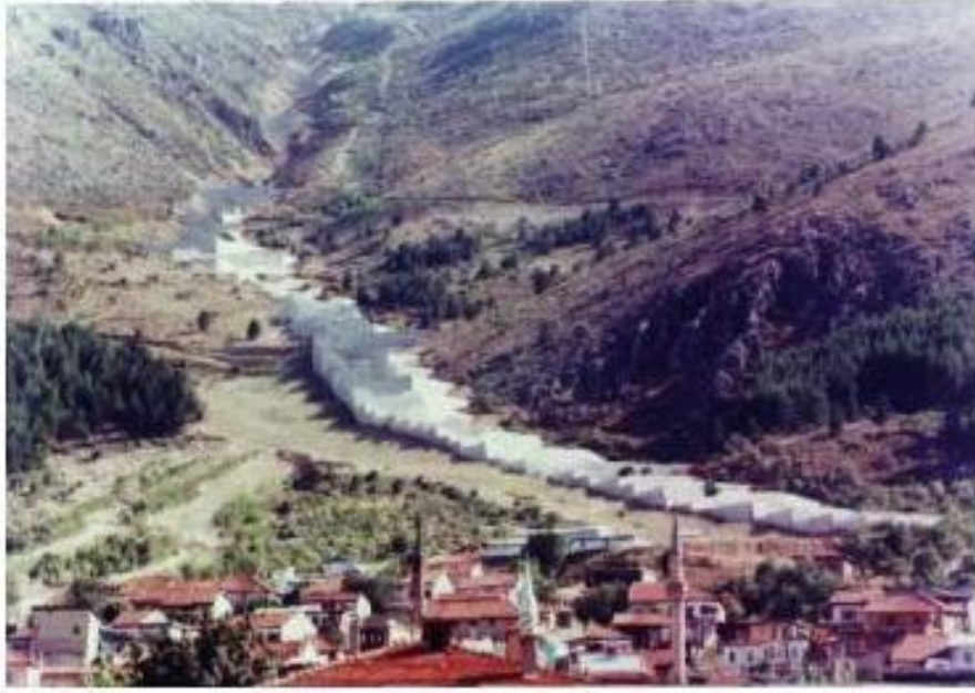
Foto-5. Senirkent'de Doğru Deresi üzerinde taşkını önlemek amacıyla yapılan sekileme sistemleri.
