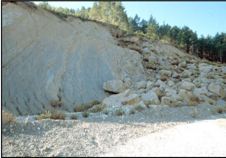
Foto-2. Isparta-Antalya arasındaki, Dereboğazı kara yolunda, duraylılığın bozulması sonucu ortaya çıkan kaya düşmeleri
