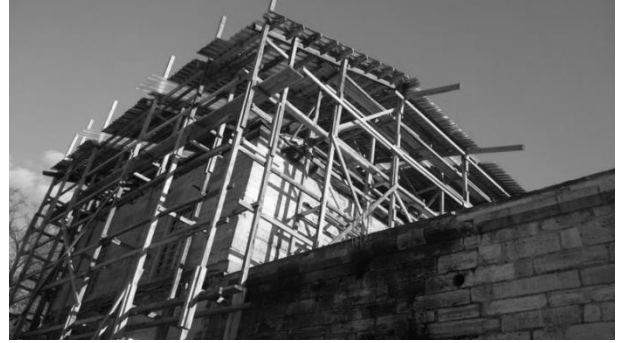
Şekil 1. Ahşap iş iskelesi (URL-1, 2016)
