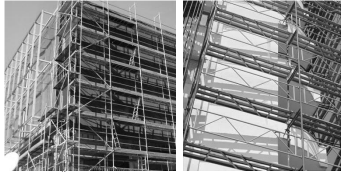
Şekil 2. Ön yapımlı çelik alaşımlı bileşenlerden oluşan iş iskeleleri (URL-2, 2016; URL-3, 2016)
