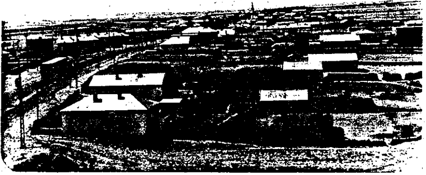
Fotoğraf 1. Köyün kuzeydoğudan görünüşü. Yolboyu formu-mesken uzanımı-konumlandırılması ve tipik konut duvarlar.
