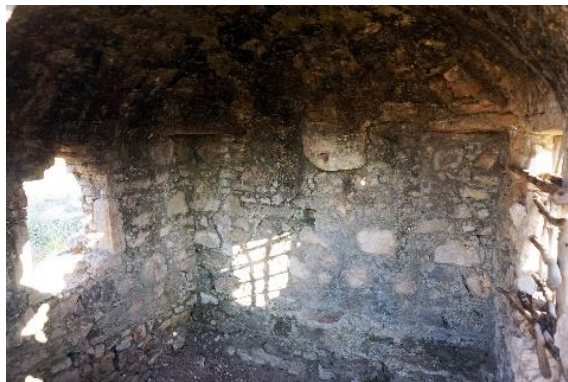
Foto.5. Hamamlıkuyu'daki Hamamcık, İç, Kuzeye Bakış (2001)
