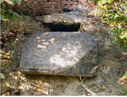
Foto. 8. Kuzeydoğu Köşe, Hazne (2001)
