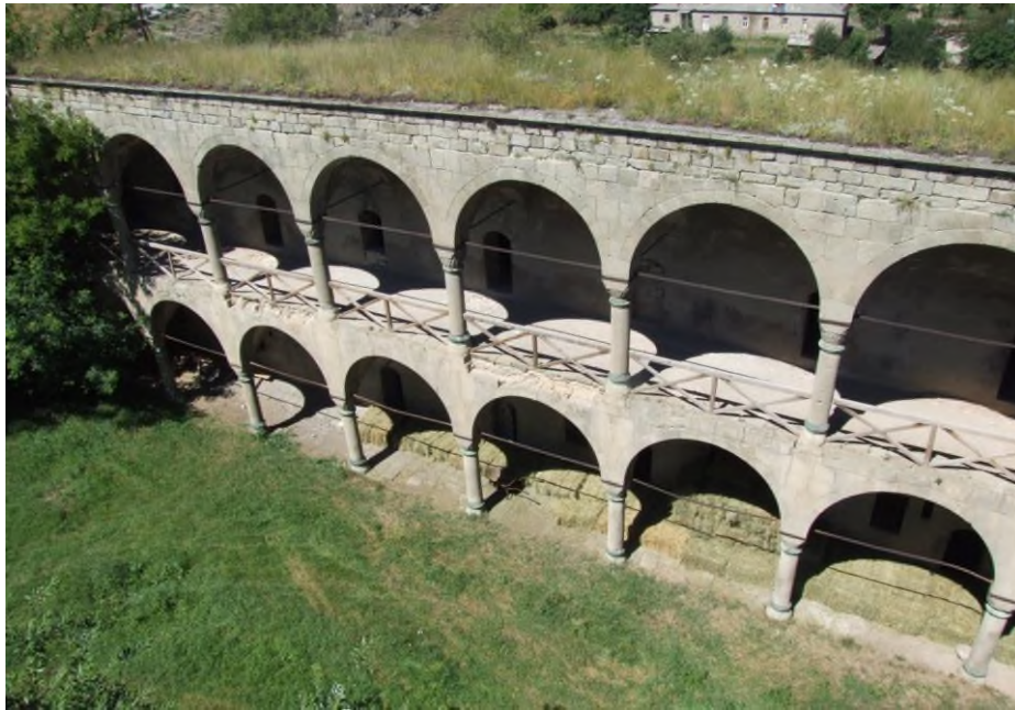
Fotoğraf 17: Ahmediye Medresesi, Restorasyon Öncesi, 2007
