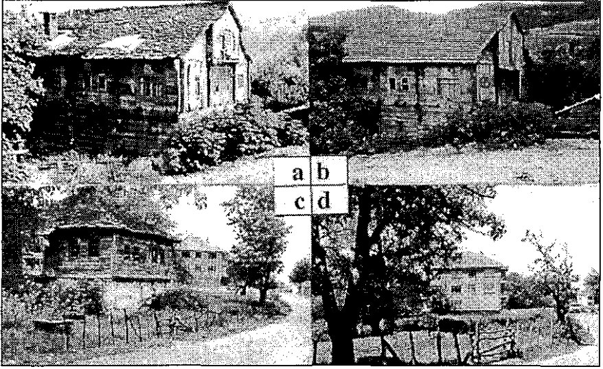
Foto 9: Çatı örtüsünde zaman içinde meydana gelen değişimler; a: Taş örtü üzerine yama yapılmış (1990) b: Aynı evin çatısı kiremitle değiştirilmiş (1997). Kayabaşı köyü (Türkeli). c-d: Taş örtülü ahşap meskenler çoğu kez de zama-na yenik düşerek taş örtüleri ile birlikte ortadan kalkıyor, Keşköy (Türkeli).
