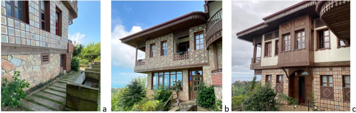
Görsel 8. Kaf Dağı Konak Otel sağır zemin kat duvarı (a), üst katlardaki çıkmalar (b), cumba ögesi (c)
