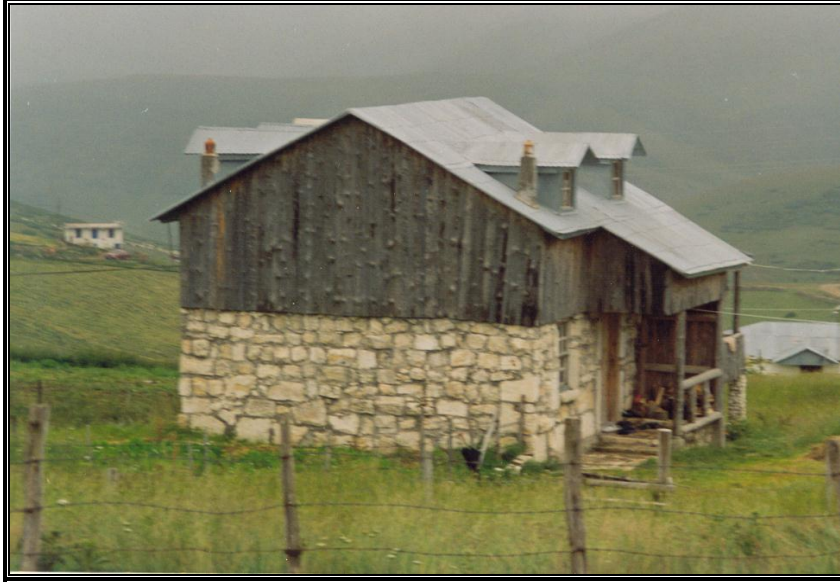
Fotoğraf 7. Oba- Yayla Yerleşmelerinde Taş ve Ahşap Malzemedен İnşa Edilmiş Yayla Evi.
