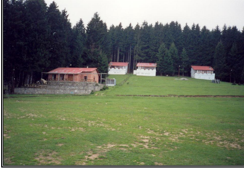
Fotoğraf . Salon Çayırı mesire alanındaki Konaklama Tesisleri
