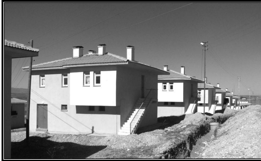
Fotoğraf 3. Ortabahçe köyünde inşa edilmiş çağdaş konutların bir bölümü.
