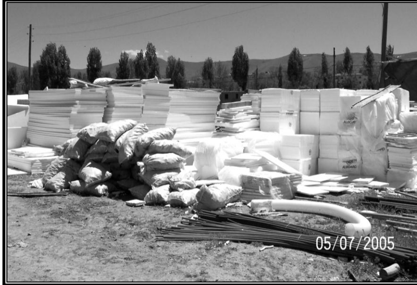
Fotoğraf 6. Kandilli beldesinde inşa edilen konutların dış duvar ve çatılarında kullanılan yalıtım maddeleri.
