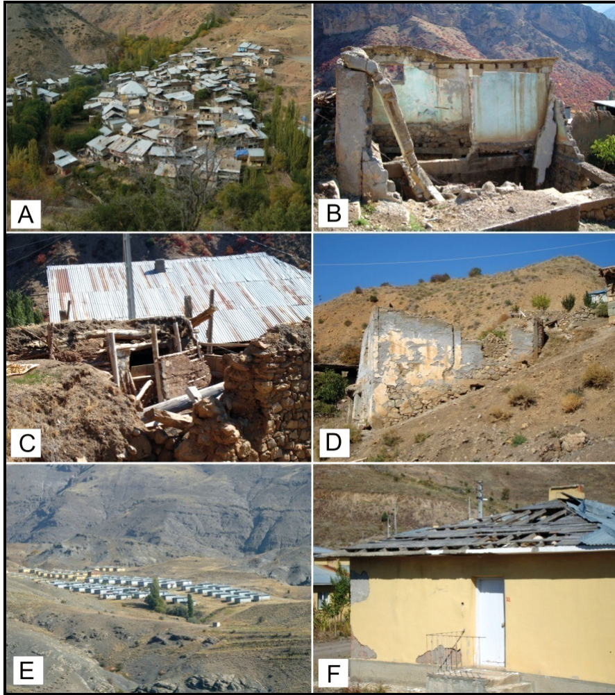
Fotoğraf 4. Elmalı Mahallesi (A) ve heyelandan etkilenen bazı konutlar (A, B, C ,D). Yurdun Mevkiinde inşa edilen afet konutları (E) ve konutlardan birinin mevcut görünümü (F).
