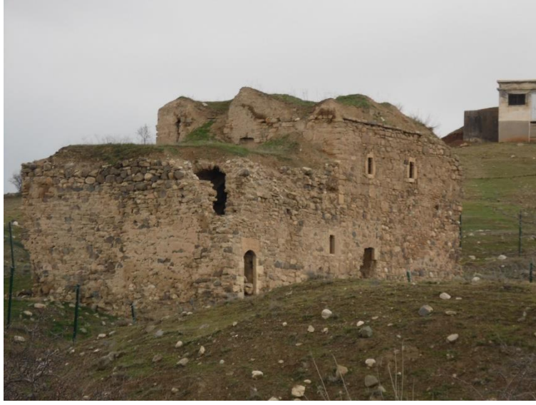
Şekil 6. Güneydoğu ve güneybatı cephesine ait perspektif görüntüsü (2019).
