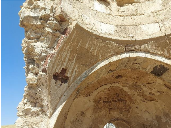
Şekil 9. Haç ve bitkisel motifli bezemelerde görülen dökülmeler ve kopmalar (2022)
