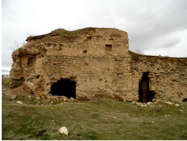
Şekil 8. Kısımlı yıkılma öncesi kuzeybatı cephesi (2019).
