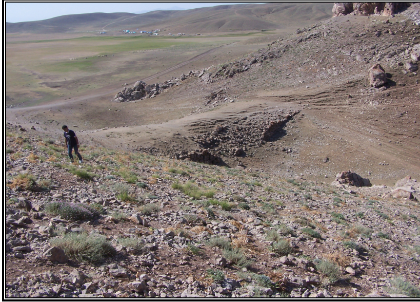
Resim2: Turna (Keşiş) Gölünü Baraja Dönüştüren Batıdaki Set
