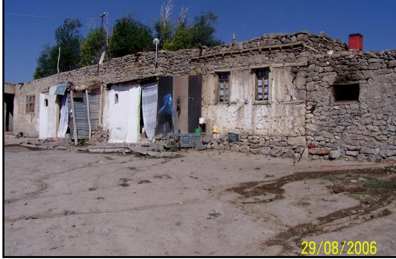
Fotoğraf 11. Yıldırım (Horasan) köyünde çevreden temin edilen malzemelerle inşa edilmiş konutlar.
