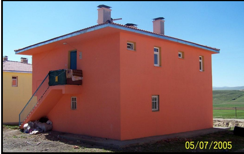
Fotoğraf 10. Aşkale depremlerinden sonra ahır eklentisi ile birlikte inşa edilmiş olan 2 katlı bir konut.
