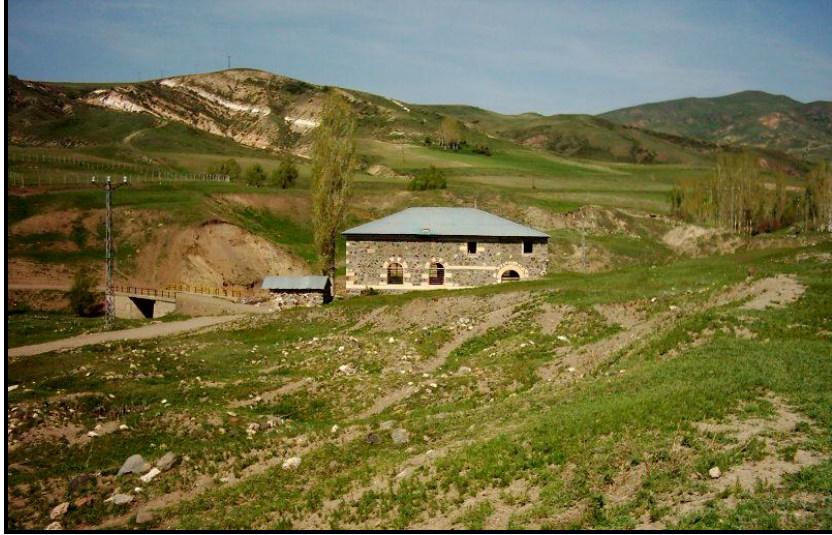
Fotoğraf 14. Erzurum-Kars Depreminde (30 Ekim 1983) köy konutlarının tümüyle ağır hasar gördüğü Gerek (Horasan) köyü camii.
