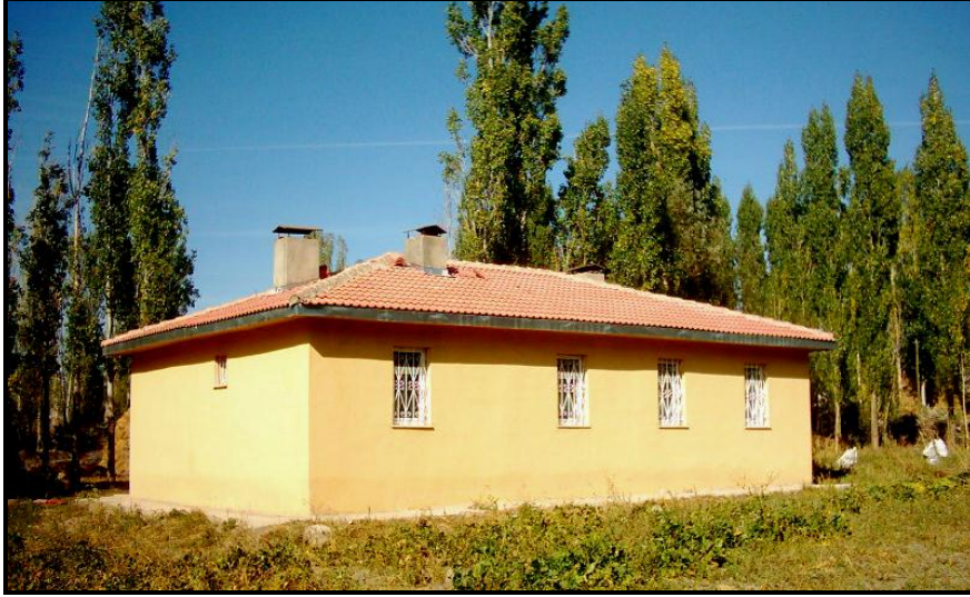
Fotoğraf 9. Aşkale depremlerinden sonra tek katlı olarak inşa edilmiş bir konut (ahır eklentisi olmayan).
