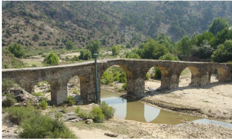
Fotoğraf 10. Gördes Çayı üzerinde bulunan Hacıhıdır Köprüsü (2010).
