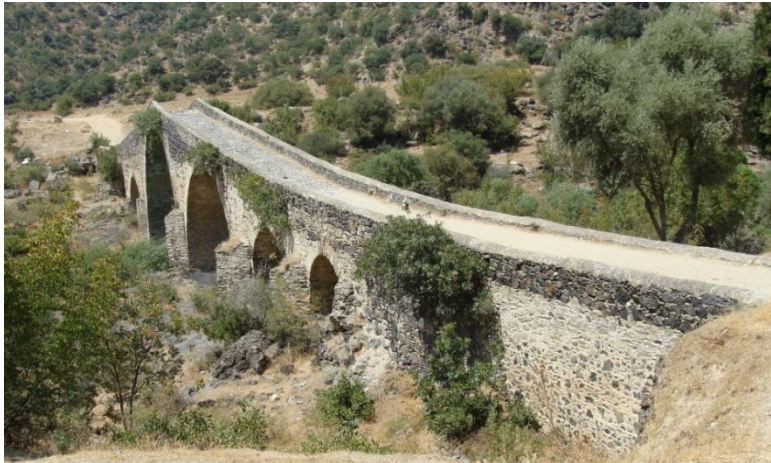
Fotoğraf 4. Gediz Havzası'nda görünümüyle dikkati çeken Kız Köprüsü (2003).
