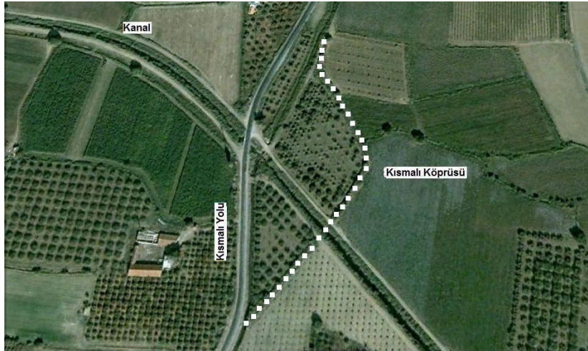
Fotoğraf 3. Kismalı Köprüsü'nün uydudan görünüşü (beyaz noktalı yerler köprüyü gösterir).
