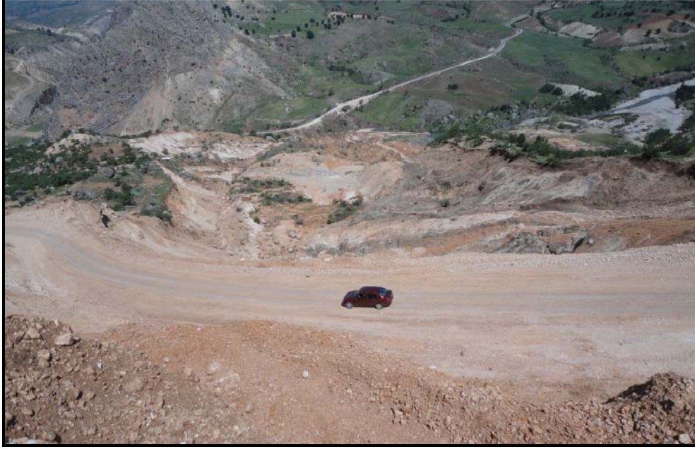
Foto 10: Heyelan sonrası hiç bir önlem alınmadan heyelanın taç kısmına yapılan yol (eski asfalt yol).
