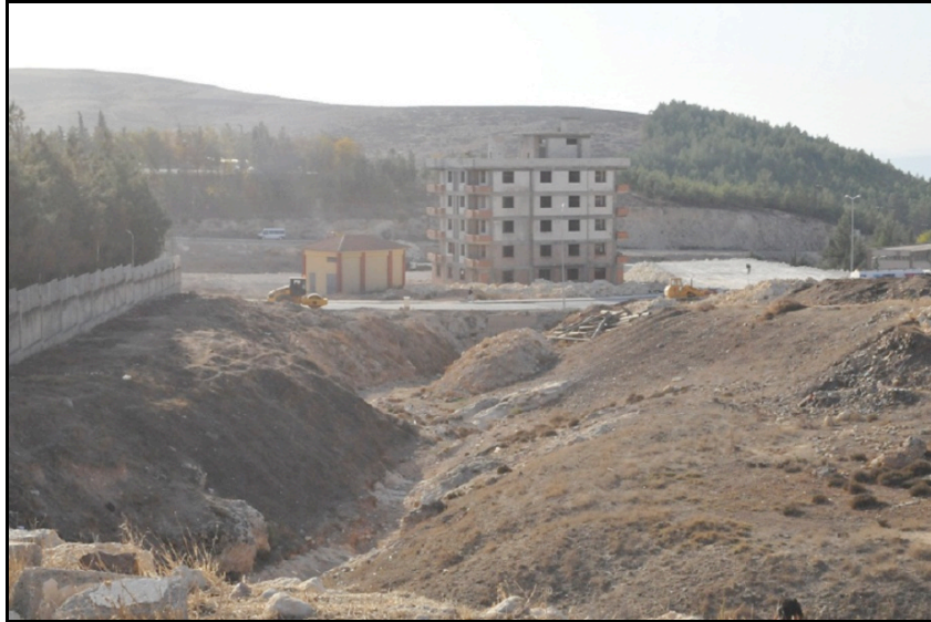
Fotoğraf 2: Afrin çayının küçük bir kolu olan derenin yatağı önce karayolu tarafından tamamen doldurulmuş daha sonra yatağın içine yurt binası inşa edilmiştir.
