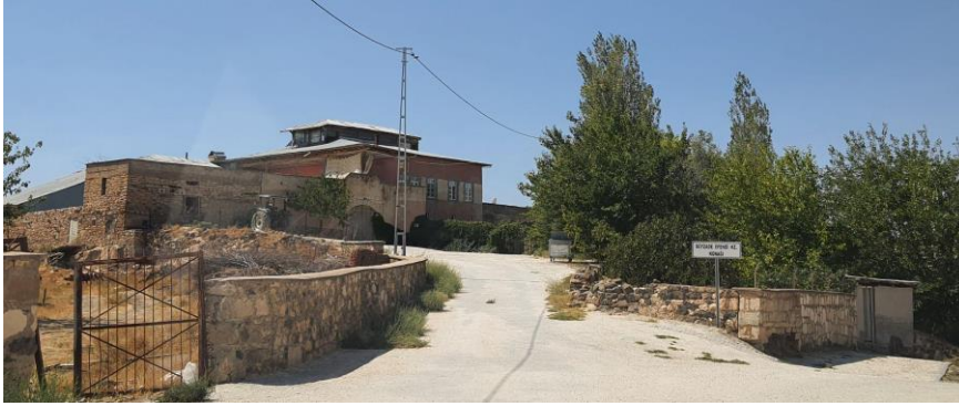
Şekil 7. Beyzade Efendi Konağı Kuzey Cephesi
