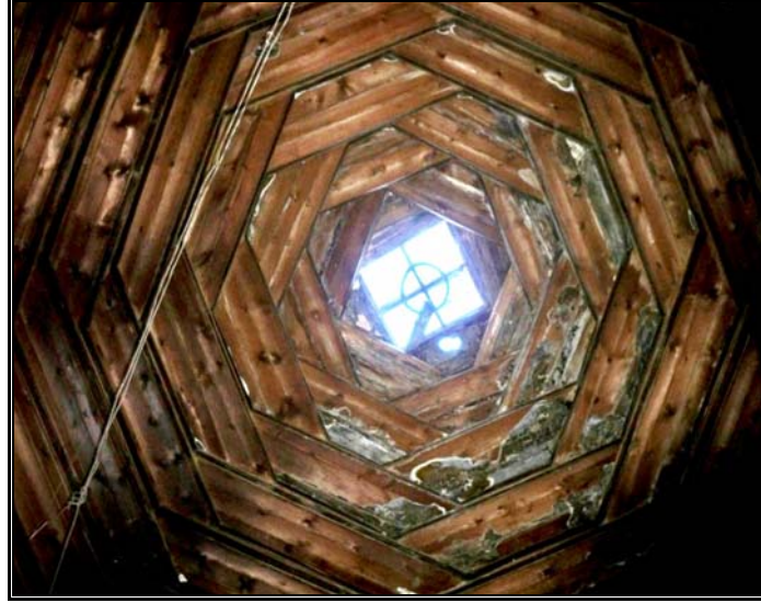
Fotoğraf 7: Kırlangıç (Karlanguş-Tüteklikli) Örtünün Anadolu'daki En Güzel Örneklerinden Biri Olan Somunoğlu Evi'nin Tandır Evinde Bulunan Karlanguş (Kırlangıç-Tüteklikli) Örtü .
