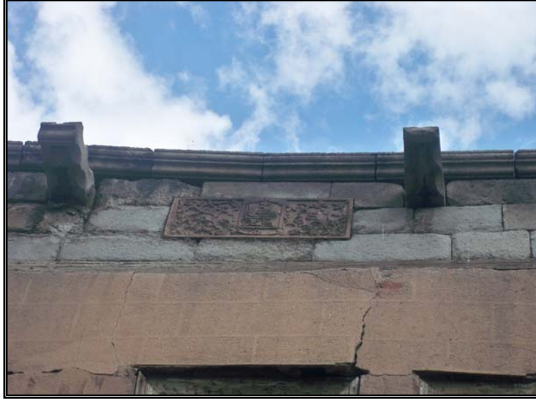
Fotoğraf 18: Vecihi Topçuoğlu Evi'nde Saçak ve Çörten Örneği.
