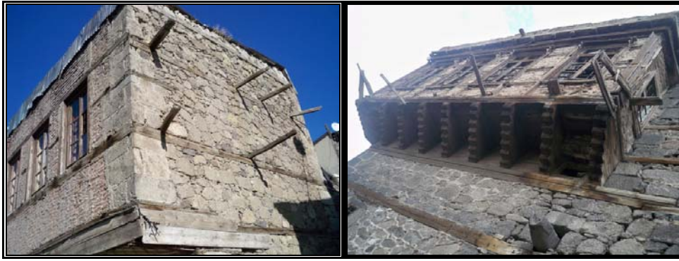
Fotoğraf 17: Hanağası Evi'nin Güney Cephesinde Bulunan Kontlar (soldaki) ve Zırnıklı Vehbi Bey Evi'nin Batı Cephesinde Bulunan Kontlar (sağdaki).
