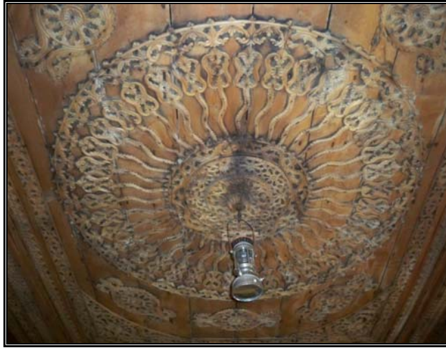
Fotoğraf 15: Hanağası Evi'nde Selamlık Odasında Çarkıfelekli Olarak Adlandırılan ve Aplike Oymalarla Süslenen, Yapımı Bir Yıldan Daha Fazla Süren Tekne Tavan Örneği.
