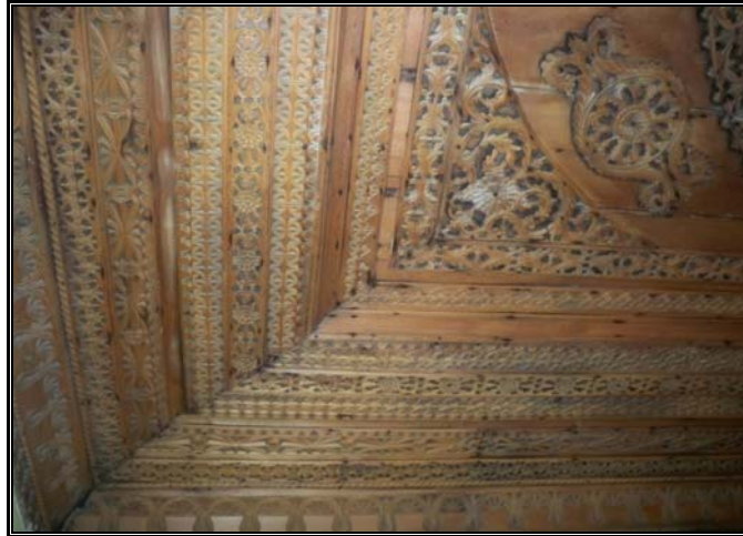
Fotoğraf 16: Tekne Tavan Olarak Adlandırılmasının Sebebi Kenarlardan Kat Kat Pervazlar Çakılarak Tavana Tekne Görünümünün Verilmesidir.
