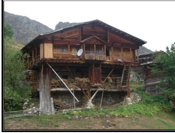
Fotoğraf 3: Köydeki geleneksel ahşap meskenler, altı hayvan barınağı olmak üzere genellikle iki katlıdır.
