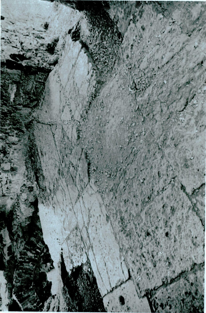
Resim 16 — Birinci Kat Salonunun Taban Döşemesi ve Havuzu
