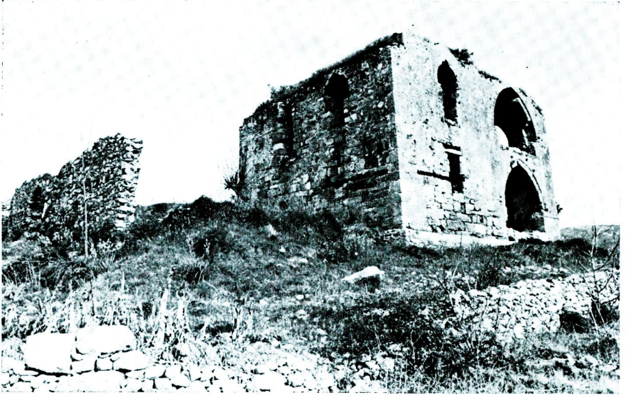
Resim 5 — Güneydoğu - Güneybatı Görünüşü ve Yan Bahçe Duvarı
