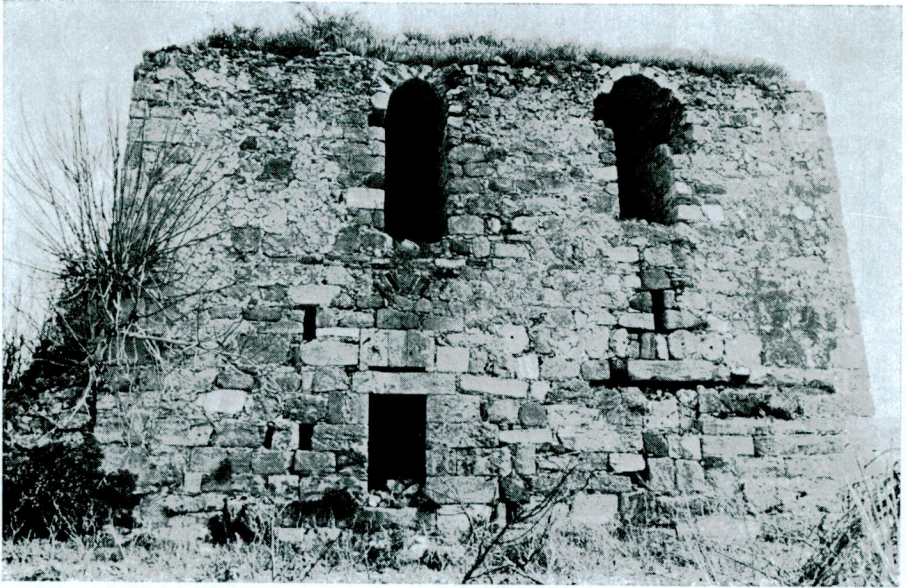
Resim 2 — Güney - Batı Görünüşü
