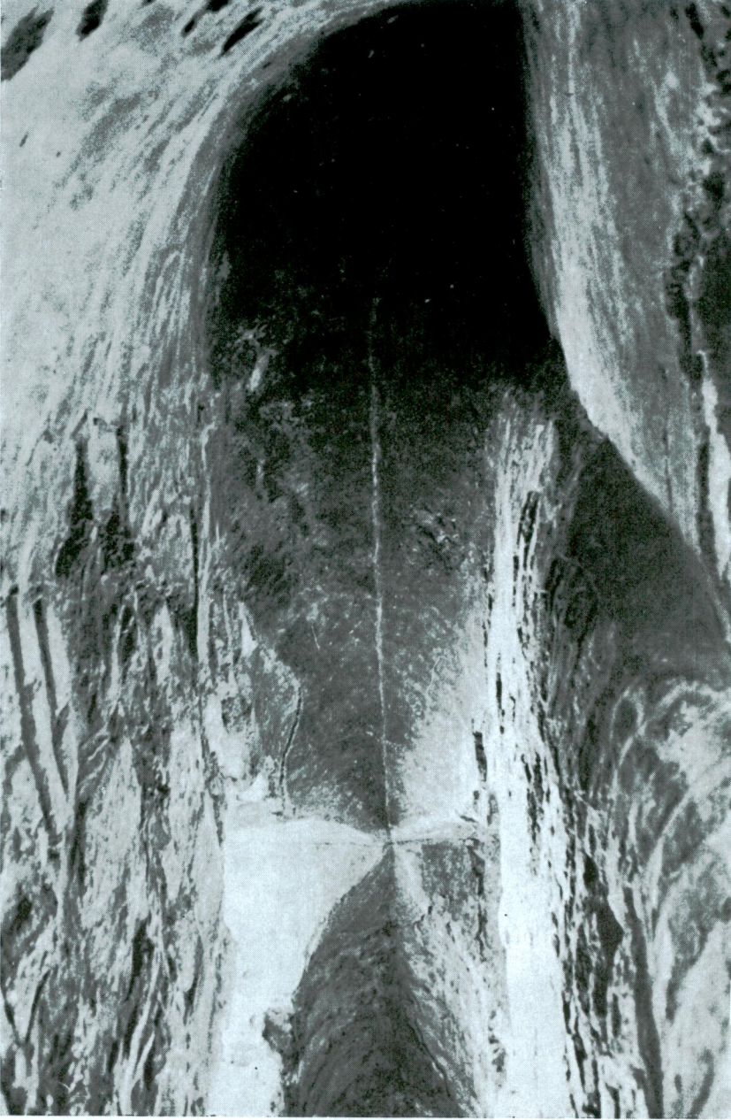
Resim 11 — Merdivenin Kuzeybatı Duvarı İçinde Kalan En Üst Kademesinin Tavanı.
