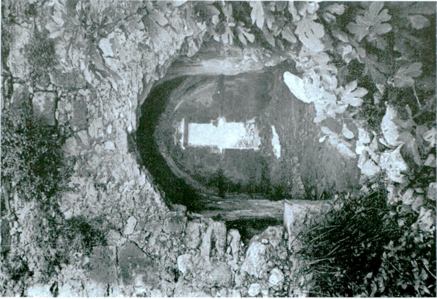
Resim 21 — Kuzey Batı Cephesindeki Ana Giriş Kapısı
