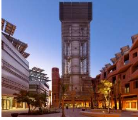
Şekil 3.13: Masdar Enstitüsü avlusunda yer alan rüzgâr kulesi (Url-13).
