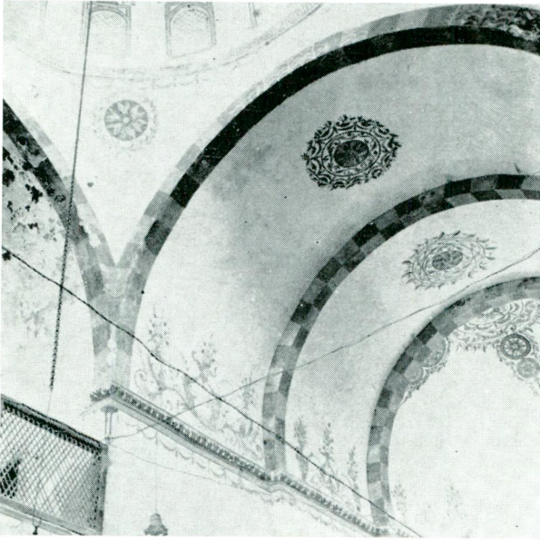
Res. 8, 9 — Vize, Ayasofya, kubbe ve tonozlar.
