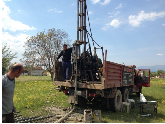
Şekil 3. Arazide SPT Deneyi Sondaj Çalışması
