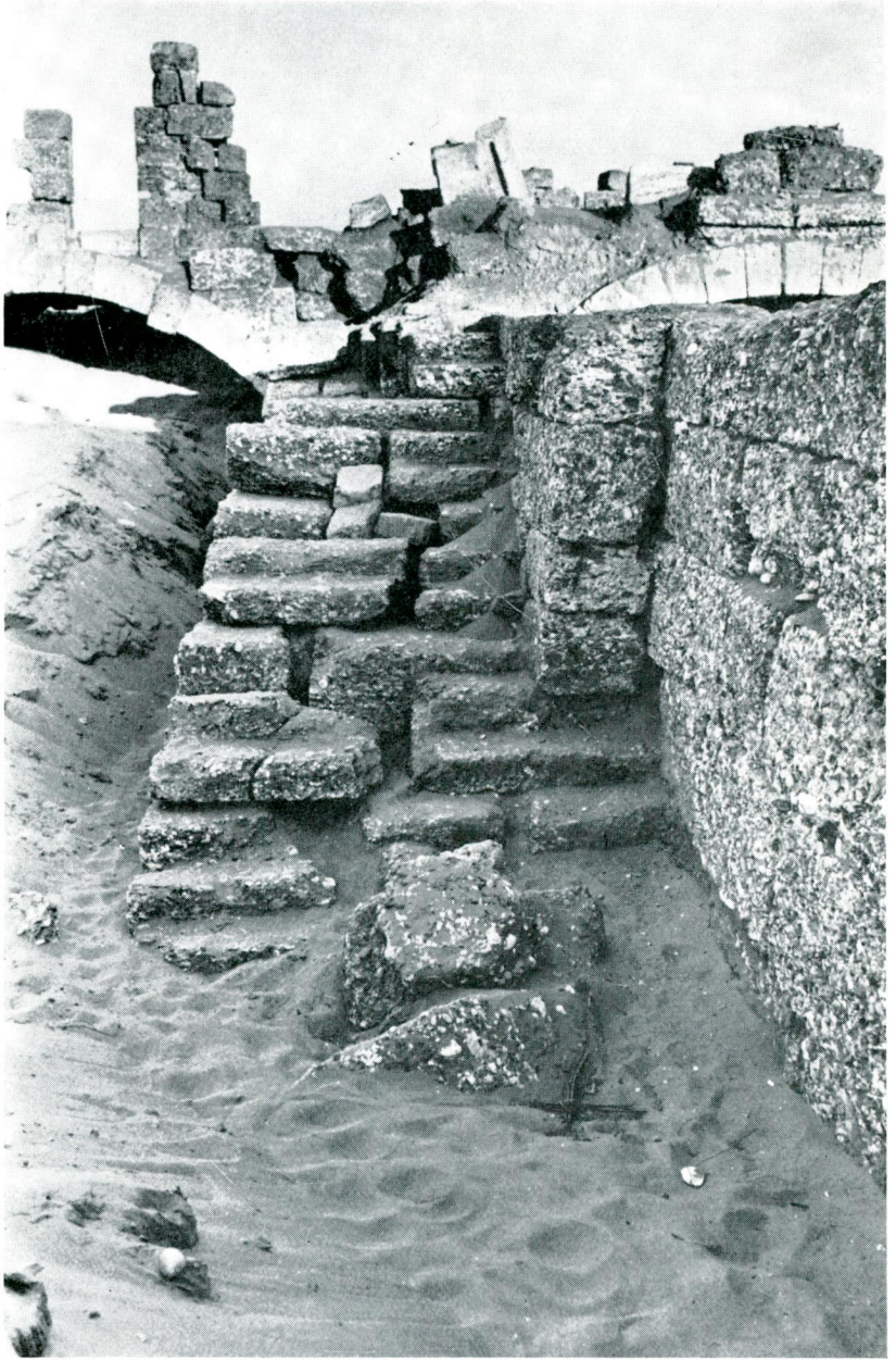
Res. 19 — Avlunun kuzey yanındaki merdivenin cepheden görünüşü
