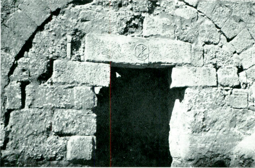
Res. 8 — C geçidinin doğu cephesi
