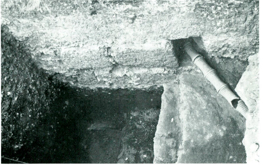
Res. 9 — A geçidinin altındaki su kanalı ve su künkü
