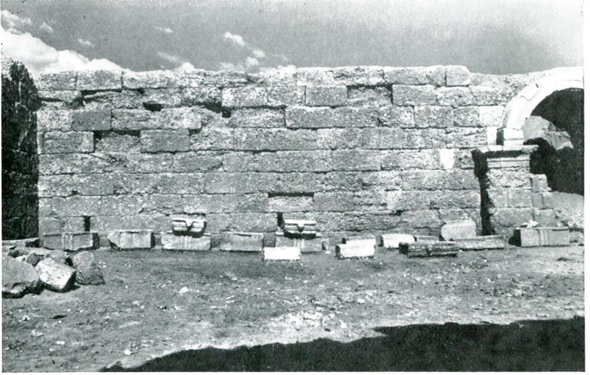
Res. 33 — Avlunun kuzey yan duvarı
