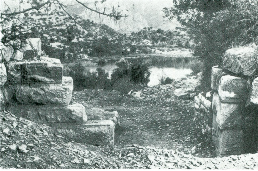
Res. 11a — Kaunos : Batı - güney şehir kapısı. Dıştan limana bakış.
