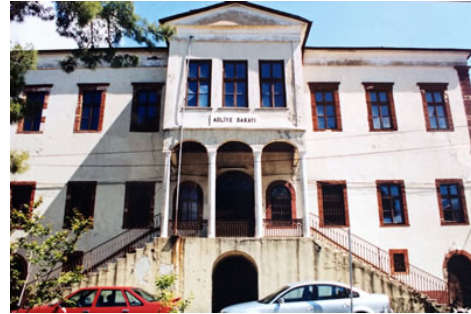
Şekil 17. Muğla Hükümet Konağı (Koca 2016)
