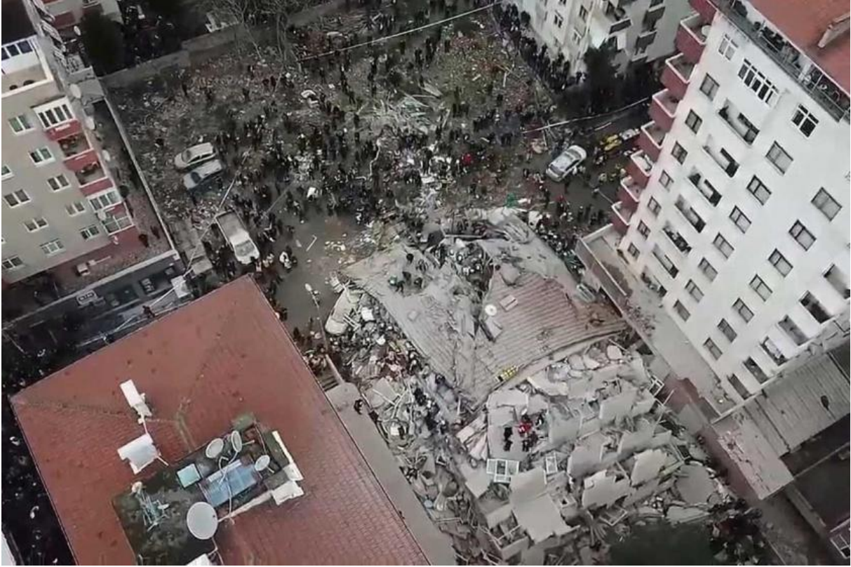
Şekil 7. Yetersiz beton dayanımından kaynaklı düşey yük altında çöken yapı (URL-1).
