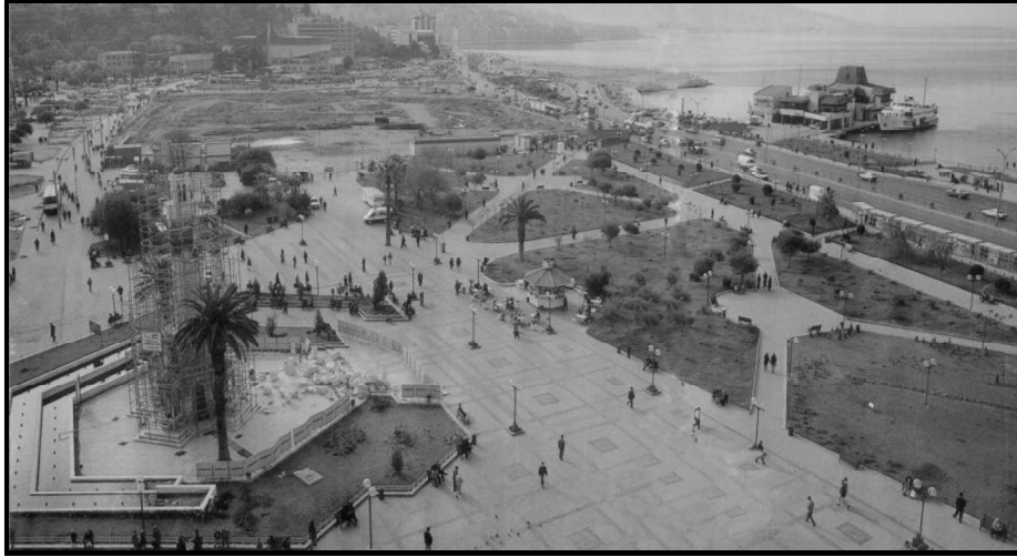
Şekil 15. Galeria İnşaat Alanı (Anonim, 1994)
