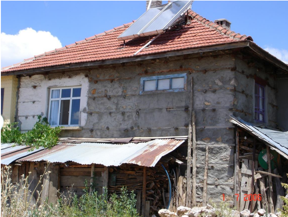
Fotoğraf 3. Pencere boyutuna, rengine ve malzemesine yapılan müdahale örneği
