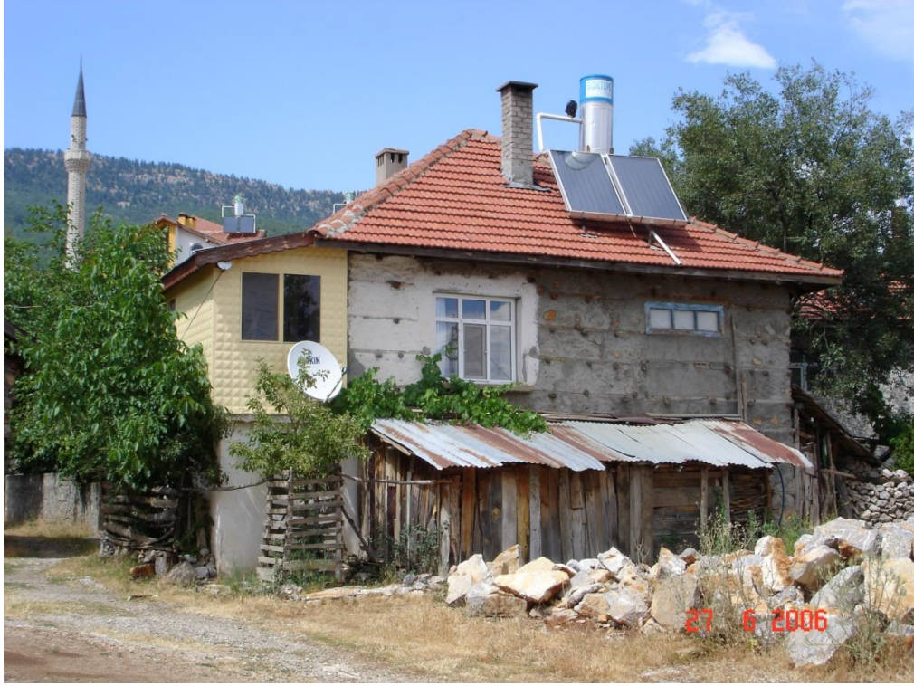
Fotoğraf 4. Mekan gereksinimi nedeniyle binaya yapılan ekler
