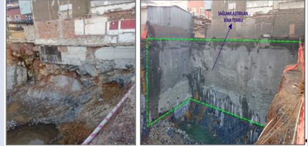
Resim 8. Sağlamlaştırılan bina temelini öncesi (solda) ve sonrası (sağda)
