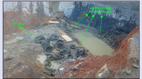
Resim 9. Patlatma Sahasının Üzerinin Kapatılması İşlemi
