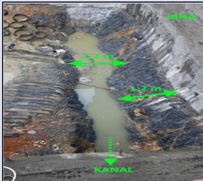
Resim 7. Serbest yüzey oluşturmak amacıyla açılan kanal
