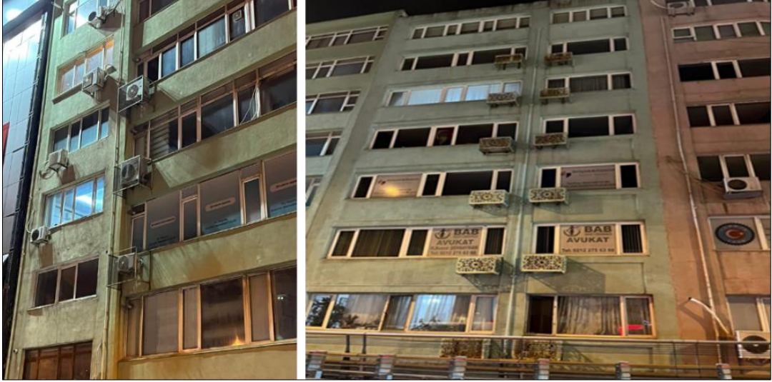
Şekil 5. Kesintisiz bina cephesi
