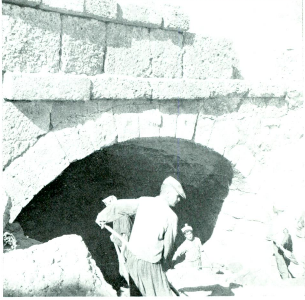
Res. 9 — Kapının (A) geçidi ve onun üzerindeki siper duvarı.
