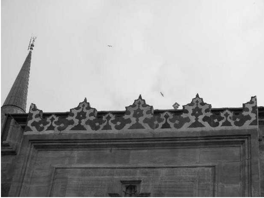
Fig. 8 Avlu kapısı tepeliği.
