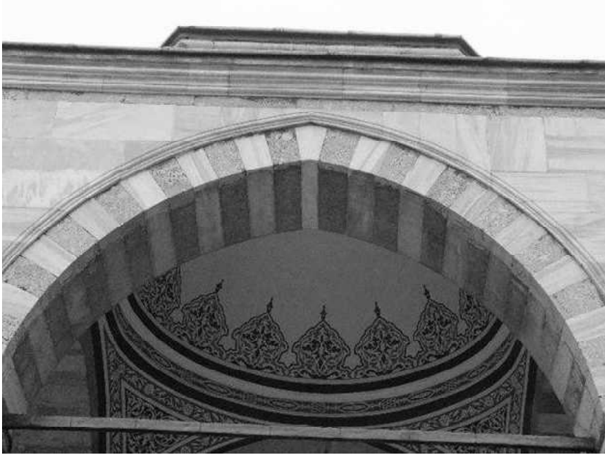
Fig. 22 Avlu revağı kemer açıklığı.
