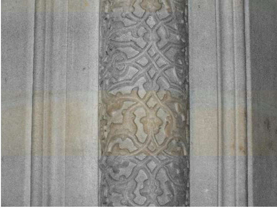
Fig. 7 Kapı köşe sütuncesi
