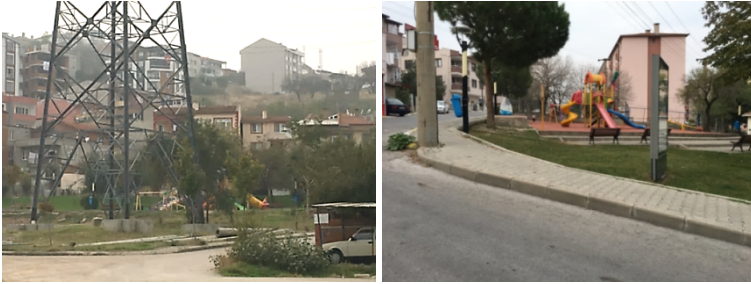
Şekil 5: TEİAŞ Balıkesir İşletme Şefliği Yakınında Bulunan Yüksek Gerilim Elektrik Direği Yanına Yapılmış Çocuk Parkı (Solda) ve Sütlüce Mahallesi'nde Yol Kenarında Koruma Bariyerleri Bulunmayan Çocuk Parkı (Sağda)
