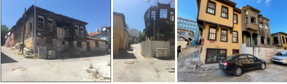
Şekil 10: Aygören Mahallesi'nde Metruk Bir Yapı (Solda) ve Aygören Mahallesi'nde Tehlike Oluşturan Eski Konut (Ortada) ve Restorasyon İşlemiyle Onarılan ve Herhangi Bir İşlemlerle Onarılmayan İki Yapı (Sağda)
